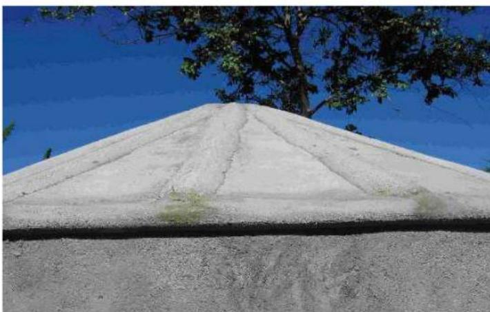
As fendas entre as placas são preenchidas com argamassa do mesmo traço usado nas paredes.
