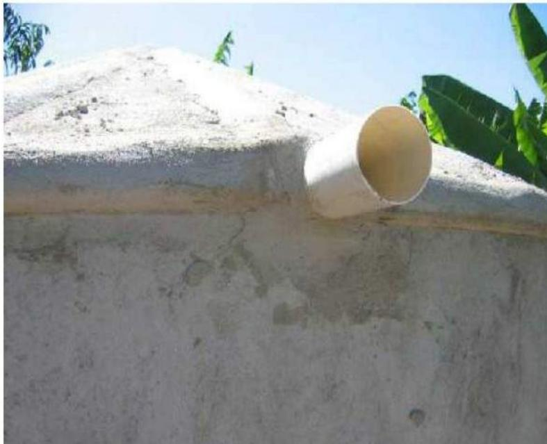
A saída para o escoamento do excesso de água, se coloca preferencialmente na junção de duas placas e não na parede da cisterna. Assim se poupa espaço de armazenamento.
