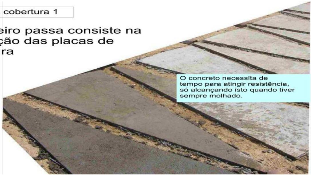
O concreto necessita de tempo para atingir resistência, só alcançando isto quando tiver sempre molhado.
