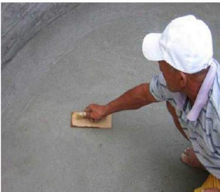
No dia seguinte à aplicação da última camada interna, se coloca no contra-piso uma camada de 4 cm de argamassa, bem compactada. Para alisar use uma desempenadeira de madeira.
