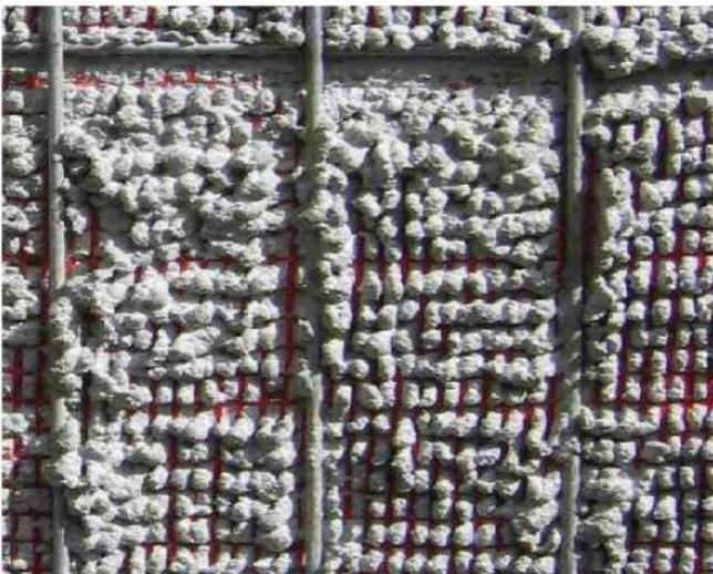
Visto pelo lado de dentro, após a aplicação da primeira camada externa: observar que a argamassa penetre bem a malha.
